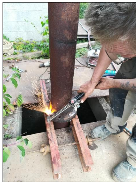
Photos n° 14 et 15 / 22 août 2017 / Clichés EGEE Développement Illustration de la difficulté de désassembler les différentes longueurs de colonne en raison de la corrosion
