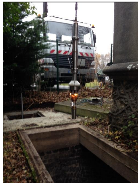
Photo n° 5 / 12 décembre 2016 / Cliché EGEE Développement Descente de la caméra dans l'avant puits
