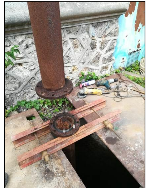
Photos n° 9 et 10 / 22 août 2017 / Clichés EGEE Développement Démontage des premiers mètres de la colonne d'exhaure
