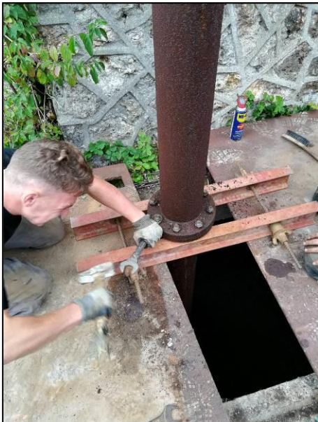
Photos n° 9 et 10 / 22 août 2017 / Clichés EGEE Développement Démontage des premiers mètres de la colonne d'exhaure
