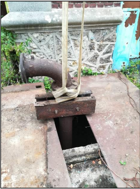
Photos n° 7 et 8 / 22 août 2017 / Clichés EGEE Développement Remontée de la colonne d'exhaure
