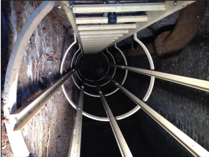
Photo n° 1 / 12 décembre 2016 / Cliché EGEE Développement Echelle d'accès au forage 19.8X.0048
