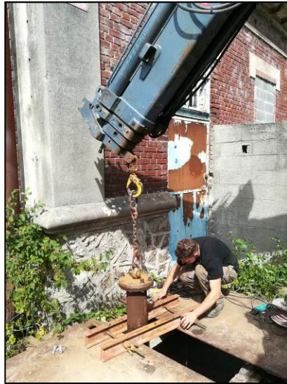
Photos n° 11 à 13 / 22 août 2017 / Clichés EGEE Développement Remontée de la colonne à l'aide d'une grue de levage
