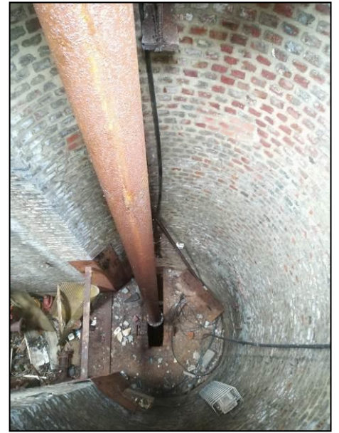
Photos n° 7 et 8 / 22 août 2017 / Clichés EGEE Développement Remontée de la colonne d'exhaure
